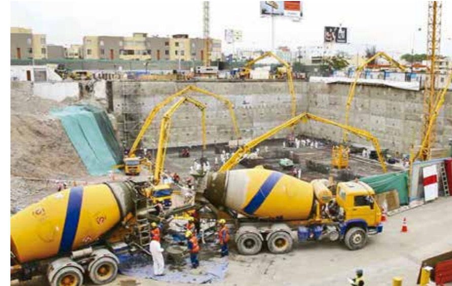
Obras en la nueva sede del Banco de la Nación
