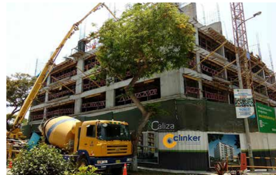
Obras en edificios residenciales
