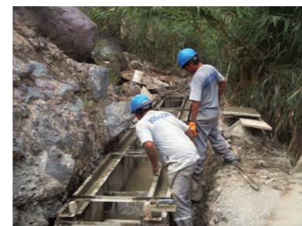
Canales en construcción
