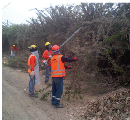
Trabajos de mejoramiento vial en la Av. Río Seco
